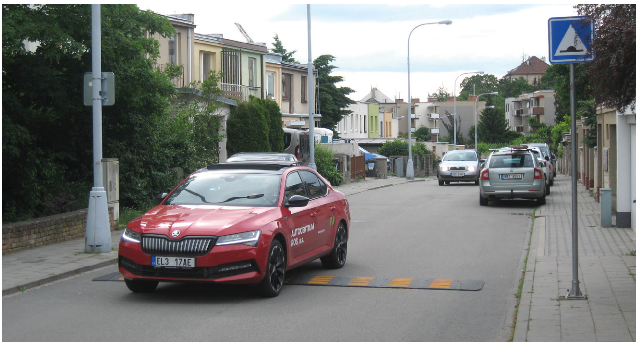
Obrázek 19. Prefabrikovaný příčný práh – překonané a nežádoucí řešení
