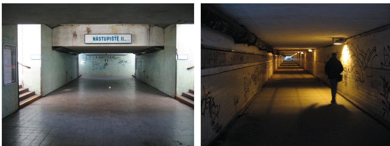
Obrázek 22. Příklady podchodu odpuzujícího (Karviná) a nebezpečného (Ostrava – Kunčice)
