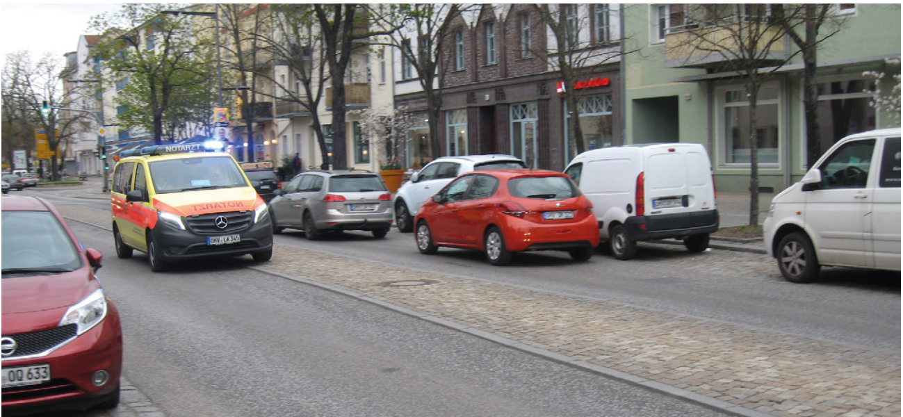
Obrázek 12. Střední dělicí pás z přírodní dlažby na průtahu dopravně významné silnice
